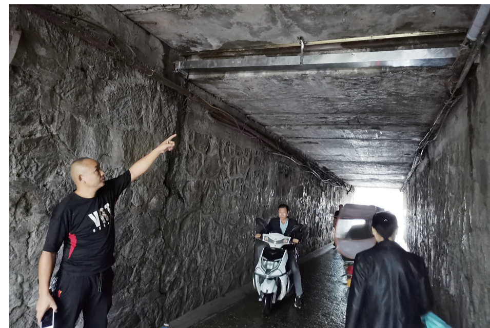
▲王伟在龙泉路涵洞装上钢槽 记者 姚时美 摄
