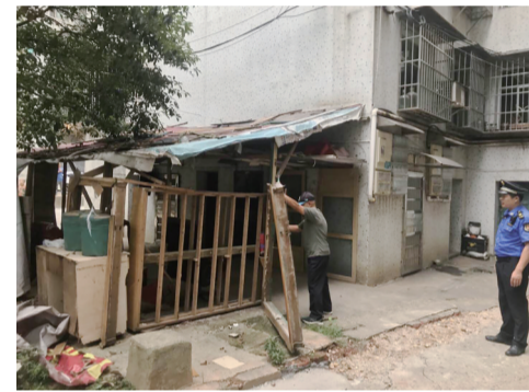
▲ 拆违现场 受访者供图
