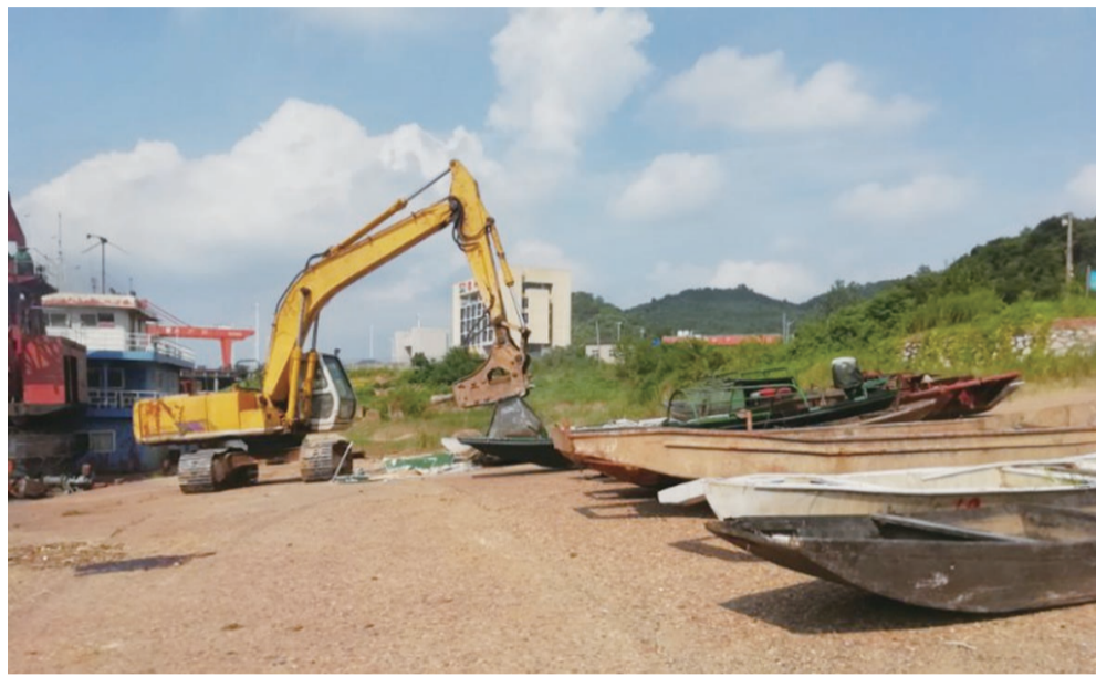
▲近日，36条渔船全部送到石峰区白祁庙码头拆卸到位 记者 李卉 摄
