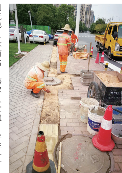
▲天元市政养护工人在火炬一街修缮盲道 通讯员供图
