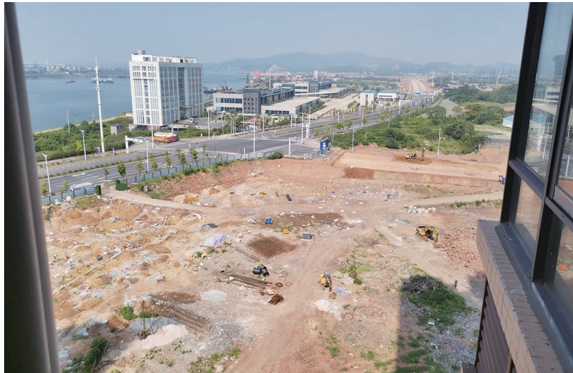
▲建设中的湘江汇项目 记者 姚时美 摄
