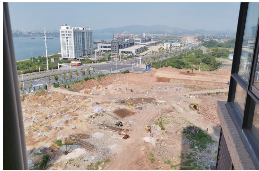
▲建设中的湘江汇项目 记者 姚时美 摄
