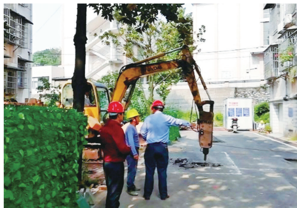
▲昨日,解放一村14栋电梯加装工程开工现场 记者 李卉 摄
