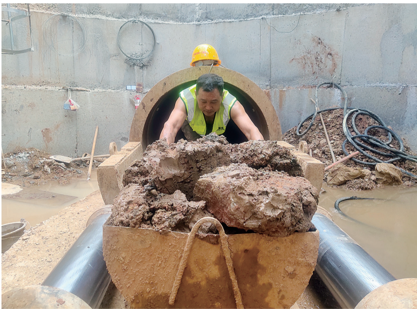
顶管作业现场，工人陈建敏正从管径1米的截污管里运出泥土、石块。廖明 摄
