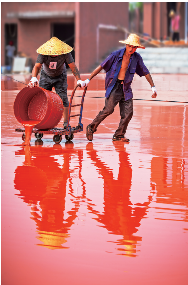
9月1日上午,市二中附小的运动场上,工人师傅顶着烈日高温,在铺设塑胶跑道。 通讯员 刘精前 摄
