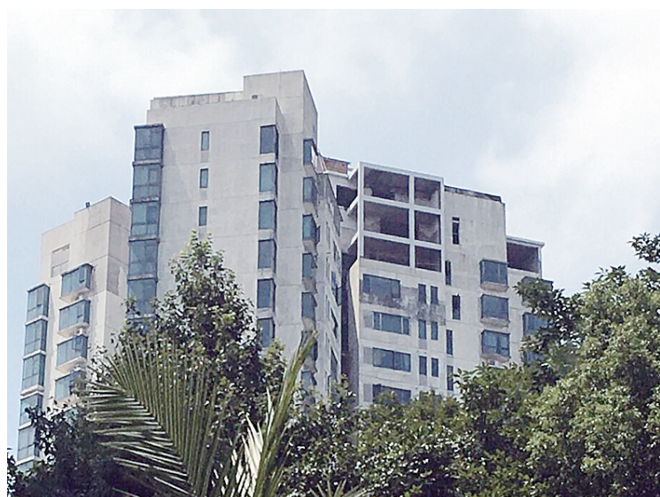
山水国际小区14栋楼顶层,有新加建的三层框架式建筑。刘平摄
