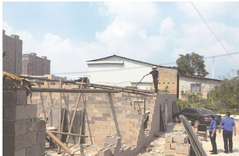
9月1日,易某在对违规搭建的砖房进行拆除。刘平 摄
