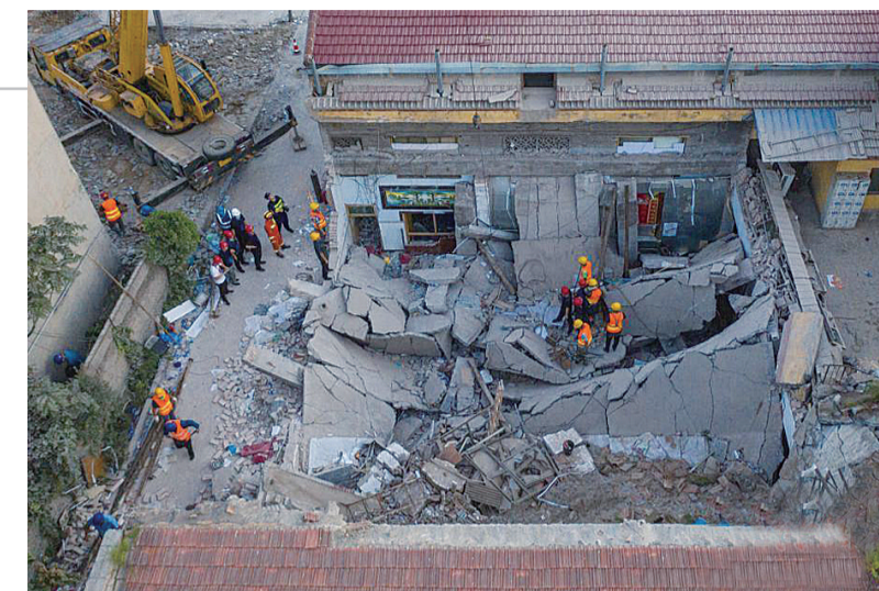
▲当时有民众在此办寿宴,房屋大厅屋顶突发坍塌
