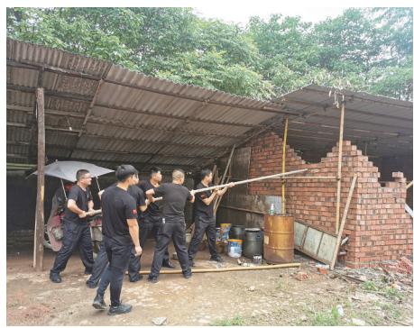
现场拆除小区违法建设
