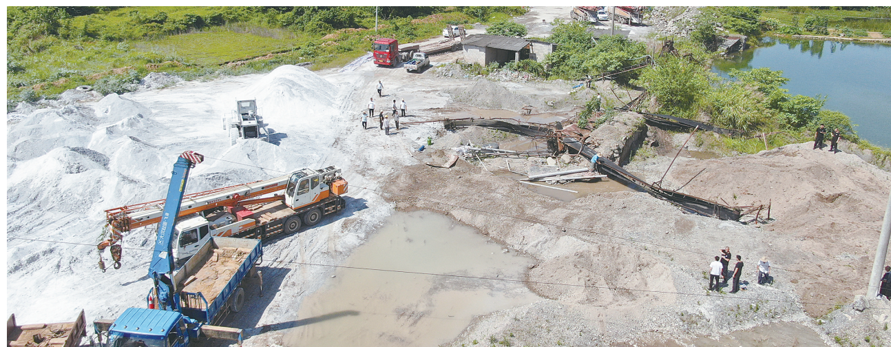
整治搬搬废并洗砂场和设备
