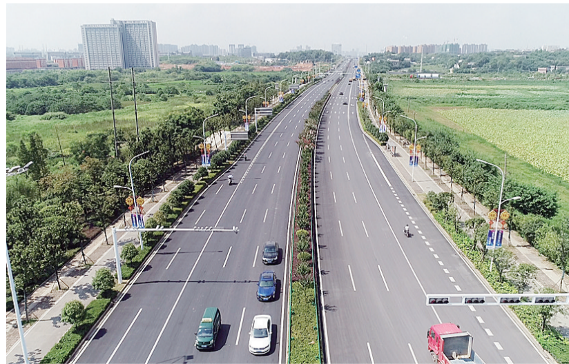
云龙大道(洞株路株洲段)快速化改造进入通车倒计时。李雄照 供图
