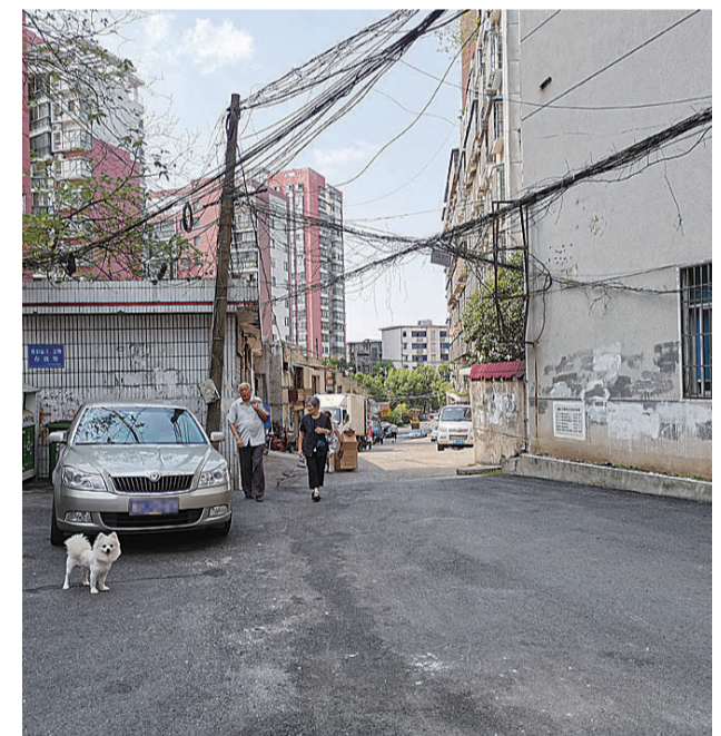
▲仁和小区内乱搭的电线、电缆 记者 姚时美 摄
