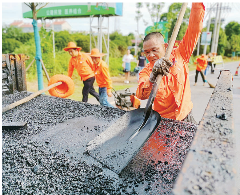
▲谭桃华从货车上铲下滚烫的沥青混凝土 记者 戴凇 摄
