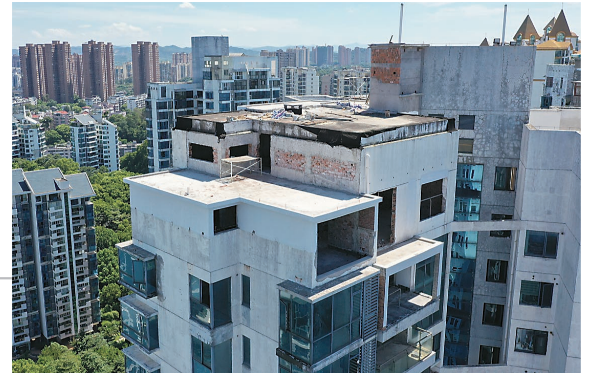
▲楼顶上加盖的违建 记者 谢慧 摄
