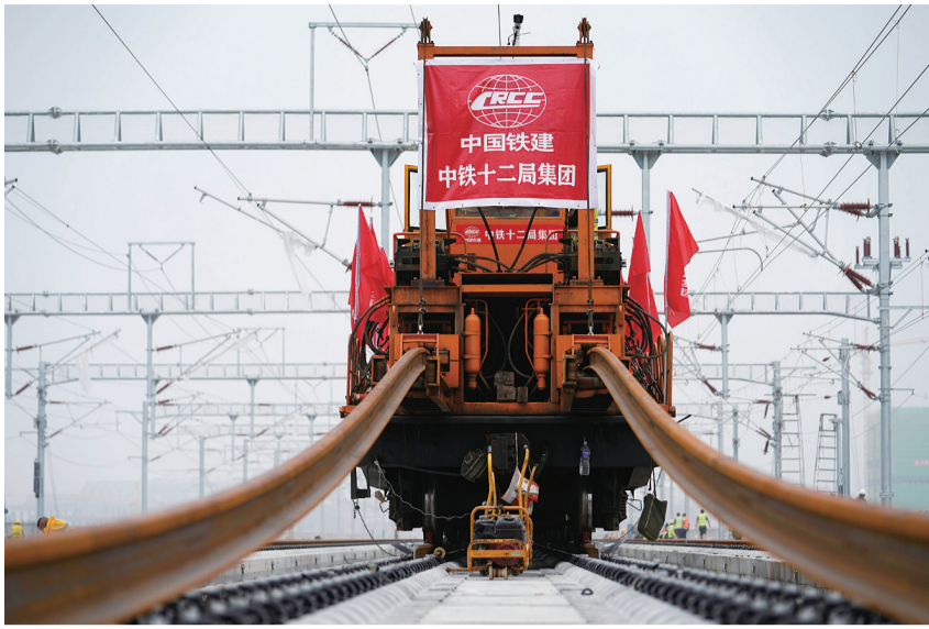
8月17日,中铁十二局的工人驾驶铺轨车在安装最后一段钢轨。新华社记者 邢广利 摄
