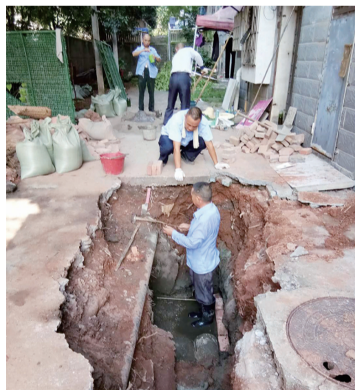
▲正在施工的芦淞区城管局市政维护队员 通讯员供图
