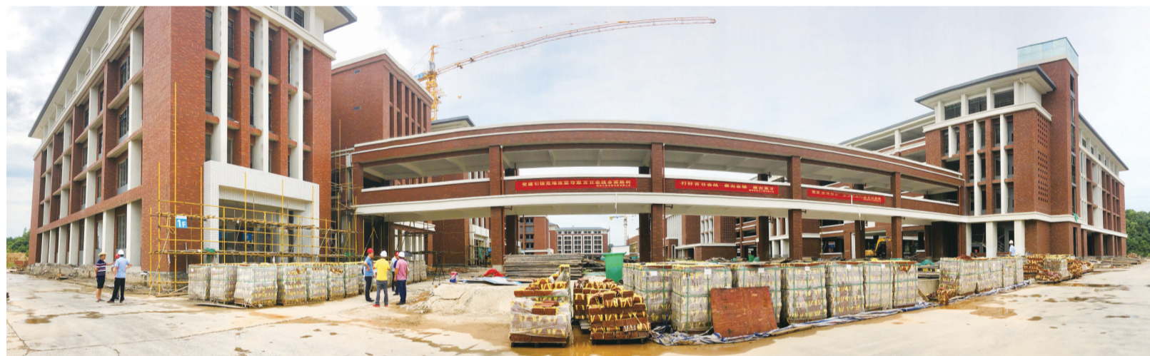
南方中学新校区完成主体建筑施工。全媒体记者 易楚瞳 摄
