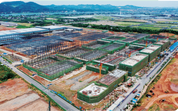
▲奇点汽车株洲基地项目施工现场。
