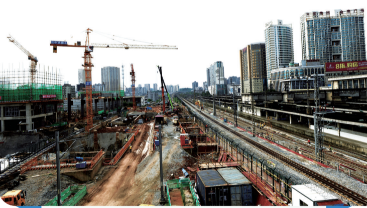
▲株洲火车站改扩建工程施工现场。
