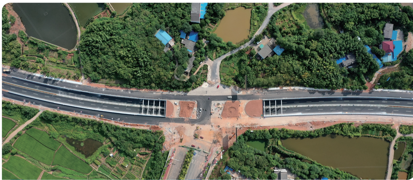
▲洞株路快速化改造项目正在进行扫尾施工。
