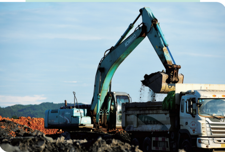
▲三一智慧钢铁城施工现场。
