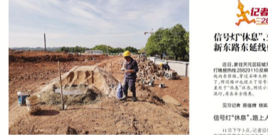
湘水湾七期项目施工现场。记者 魏英杰
