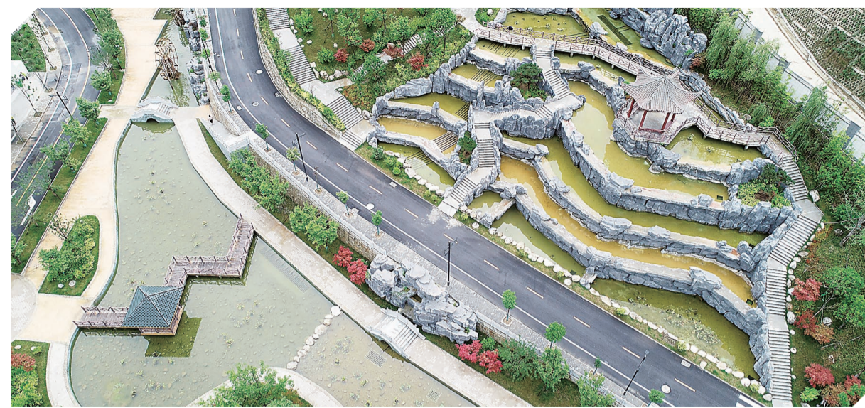
▲镇安县镇安中学多级瀑布群与水池栈道凉亭景观
