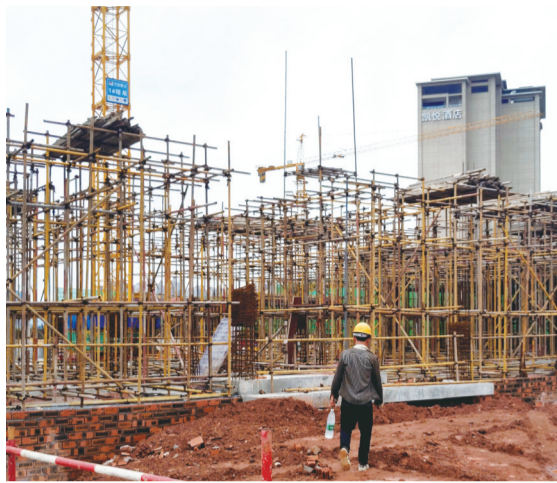
晋合·湘水湾项目七期施工现场。沈全华 罗伯钊 摄
