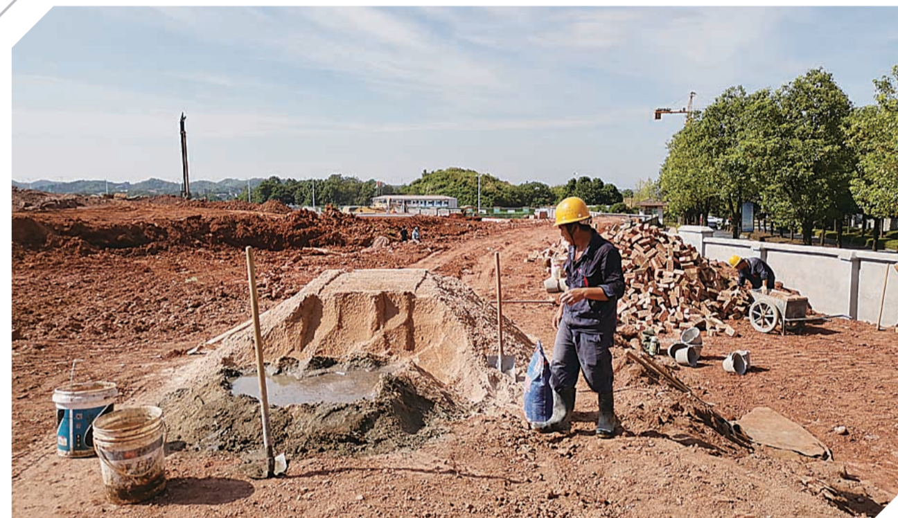
▲8月9日,湘水湾七期施工现场 记者 姚时美 摄
