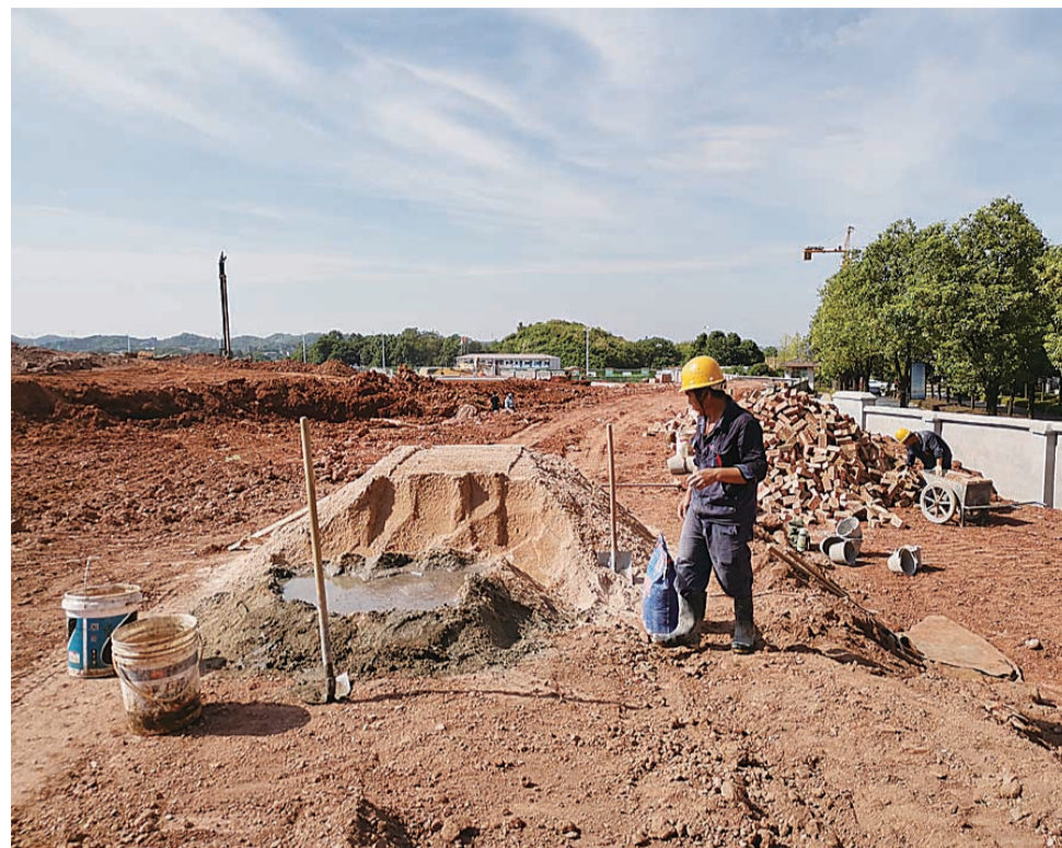
▲8月9日,湘水湾七期施工现场 记者 姚时美 摄
