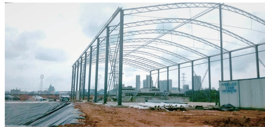
▲新民路口主排渠黑臭水体整治中的标志性工程污泥固化场预计8月15日可以投入使用 记者 李卉 摄
