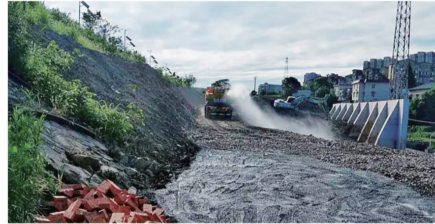
▲时代大道南辅道施工现场 通讯员供图
