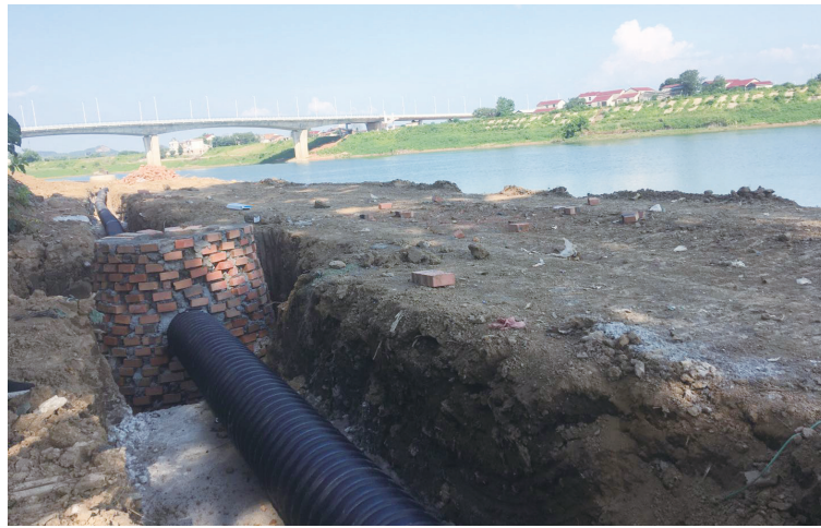
醴陵县老街居民生活污水截污纳管工程现场。株洲日报记者 俞强年 摄
