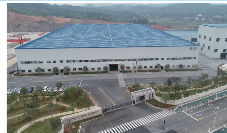
▲五建建筑工地
