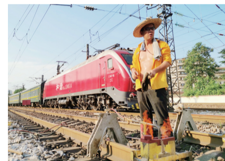
▲护路工人用火枪对铁轨加热 记者 戴凛 摄
