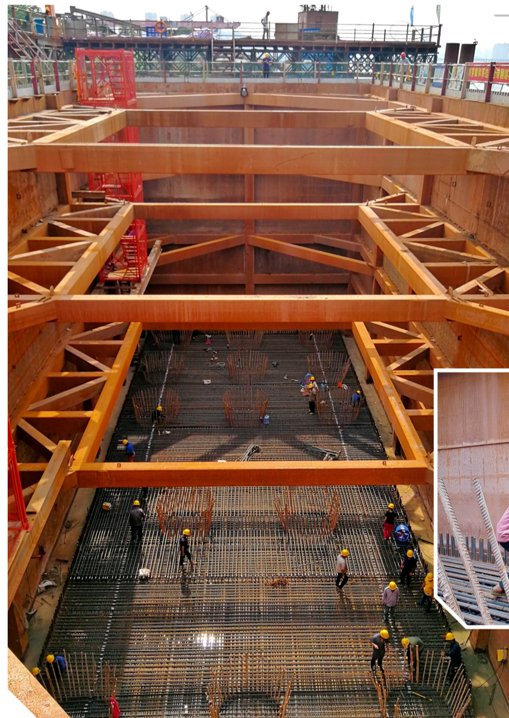
◀清水塘大桥22号主桥墩的部分施工人员在低于水面13米的场地作业,但头顶并无任何遮挡 记者 李卉 摄
