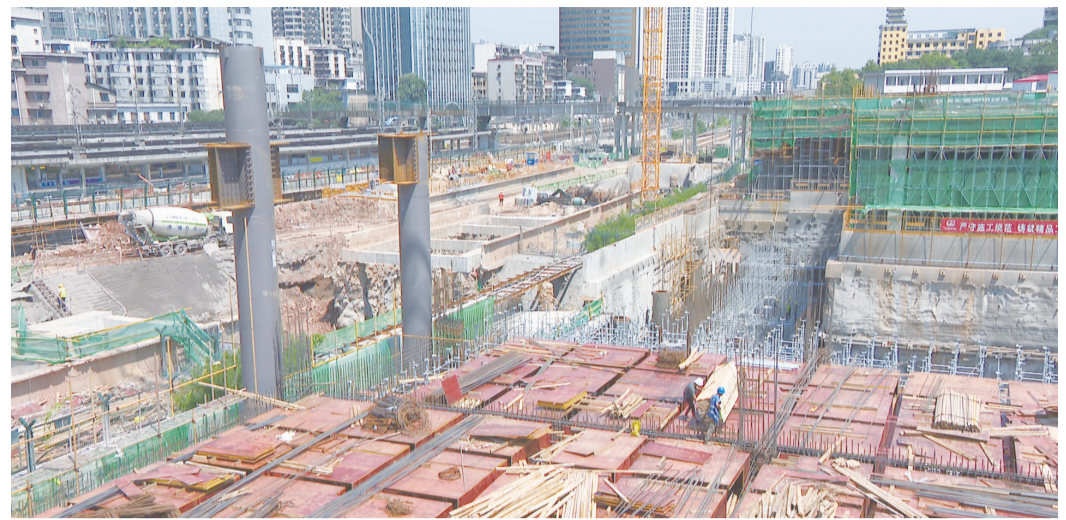
火车站施工现场。吴楚/摄
