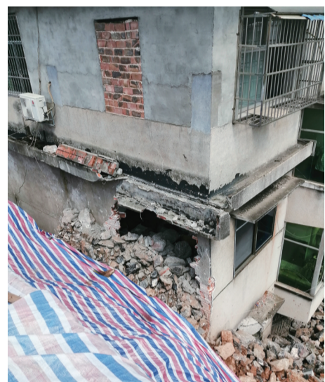
护坡垮塌时，二楼墙壁被砸穿。 株洲日报社全媒体记者 陈驰 摄
