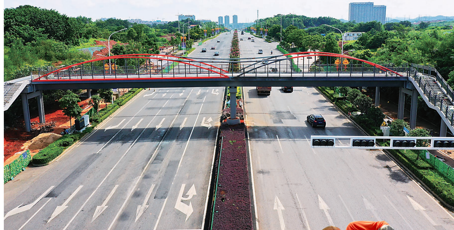
▲改造项目全程共有六座人行天桥
