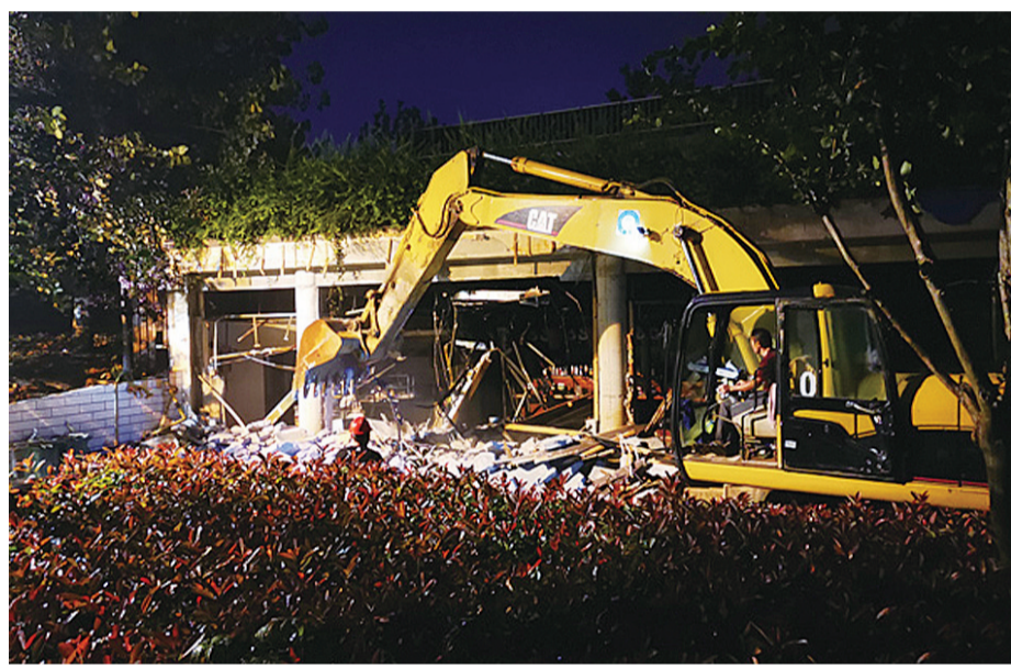
▲7月26日,南京市相关部门组织对违建的门窗、装修设施、砖砌墙体等进行拆除
