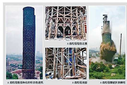
全钢结构造粒塔成功爆破过程。株洲晚报 提供
