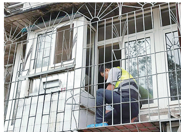
▲安装师傅正在进行油烟机安装调试 通讯员供图
