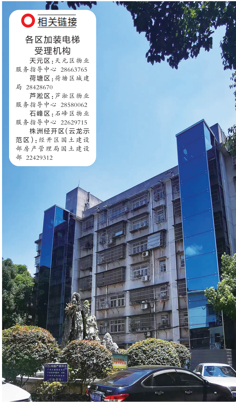
老市政维护处小区加装的电梯在阳光下分外亮眼。通讯员 供图
