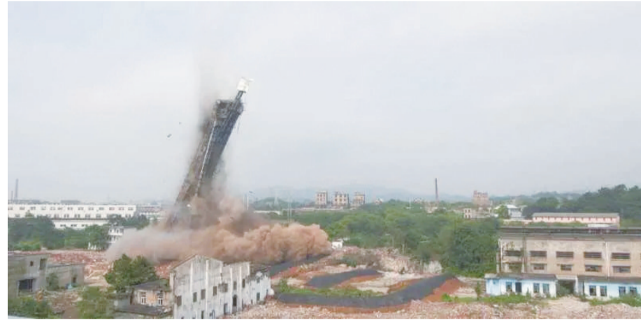
造粒塔爆破现场。通讯员 供图
