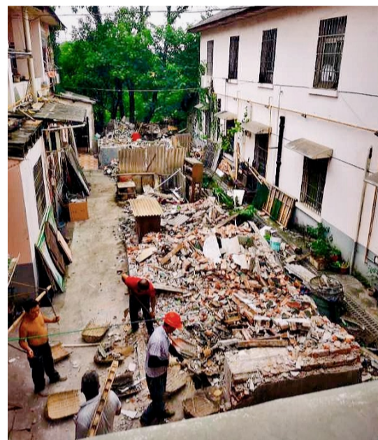
▲曹四村小区的违章建筑已被拆除完毕
