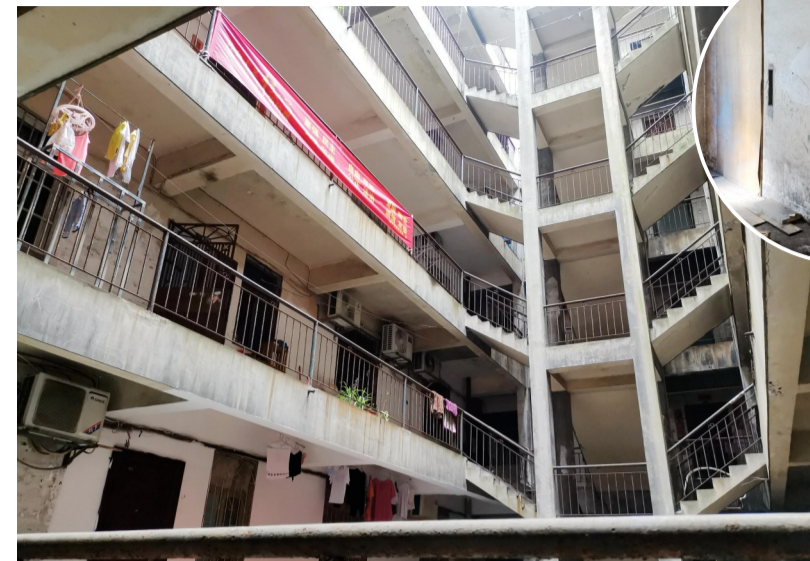
▲由于楼栋电梯停摆拆除,很多居民已搬离 记者 戴凛 摄
