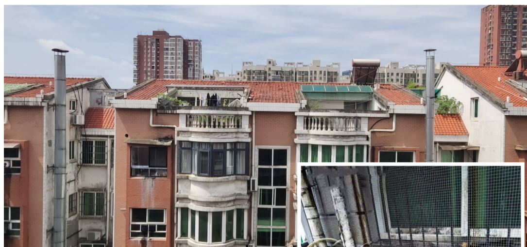
▲湘银小区某餐馆的油烟管道一到就餐高峰时,就会排出气味很重的油烟 记者 杨凌凌 摄
