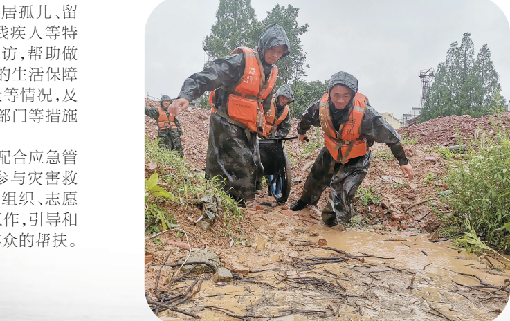
7月15日,在安徽铜陵枞阳县白荡湖岸堤上,东部战区陆军第72集团军王克勤生前所在连官兵结成互助小组,运送土石加固于堤。
