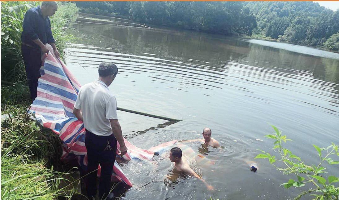
抢修水库现场。通讯员供图
