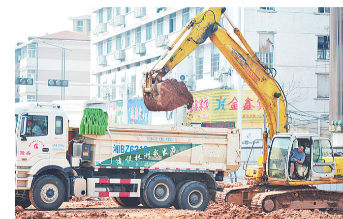
▲昨日,响石广场隧道核心段开挖现场
