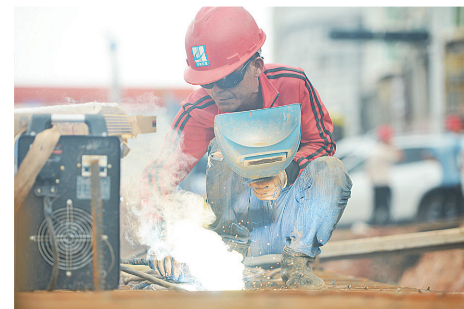
▲响石广场改造现场,工人师傅在焊接钢梁
