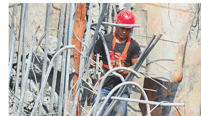
▲昨日,工人师傅在拆除前期施工与维护装置
