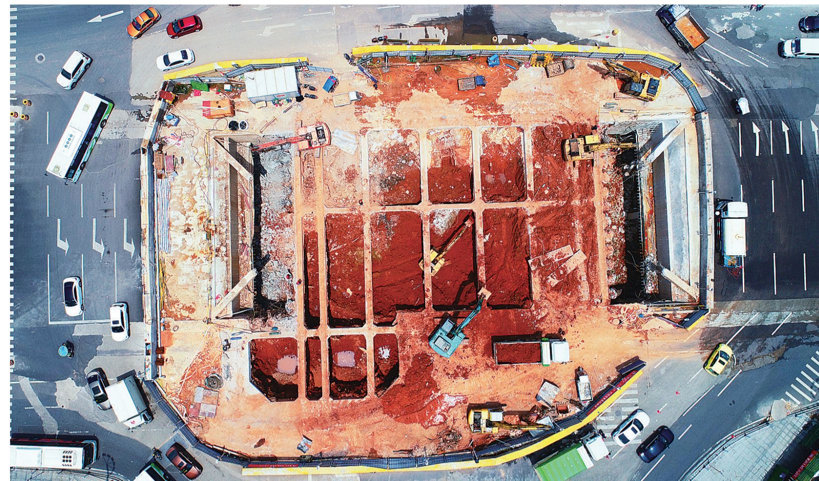
▲昨日,响石广场隧道核心段正在施工,目前辅道已基本成形
