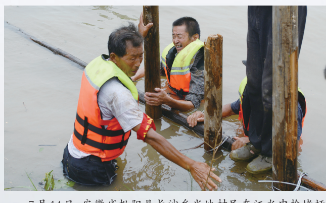
7月14日,安徽省枞阳县长沙乡当地村民在江水中抢堵圩堤管涌。
