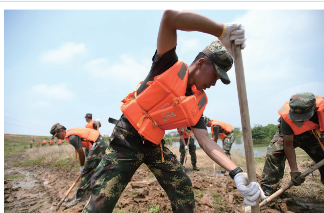
7月14日,火箭军某部官兵在江西南昌新建区联圩镇五星圩大堤下挖掘导水沟。
