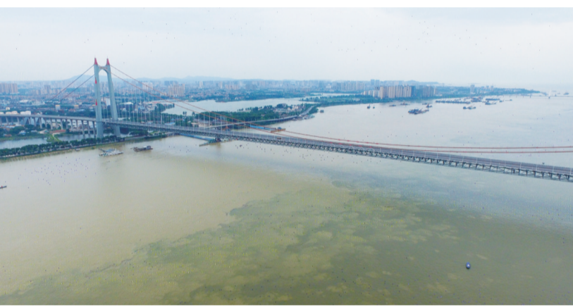
7月12日拍摄的超保证水位下的岳阳洞庭湖特大桥。新华社记者 陈泽国 摄
