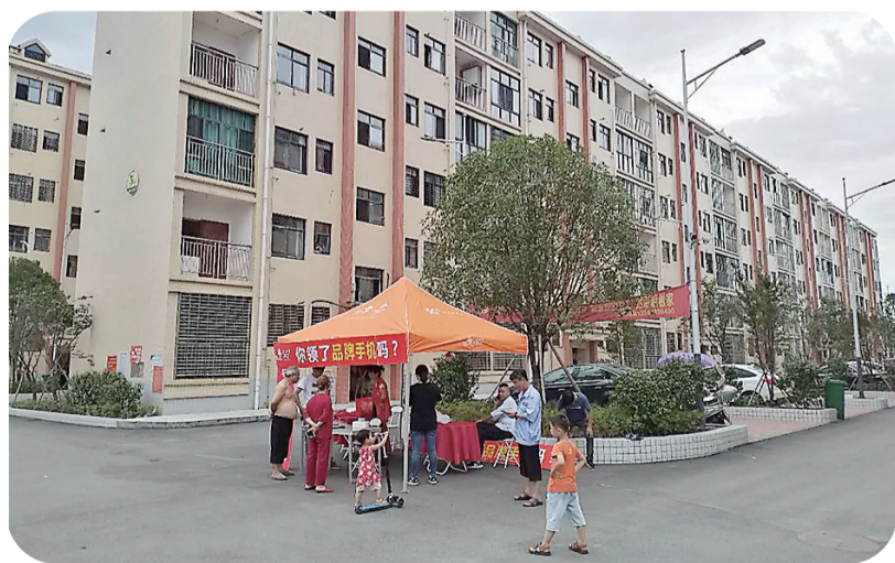
攸县在联星街道枫岭组建设的保障性公租房。洪华第 供图
