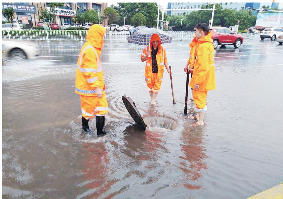
7月10日上午，神农大道市民中心附近，天元区市政维护中心工作人员在疏通下水管道。 通讯员 供图
