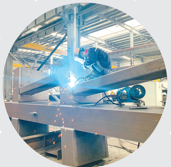
中天杭萧生产车间内火花飞溅。吴楚/摄
