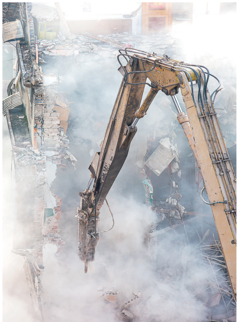
▲ 编号 NL6 房屋拆除现场,臂长20米的炮机正在作业。
