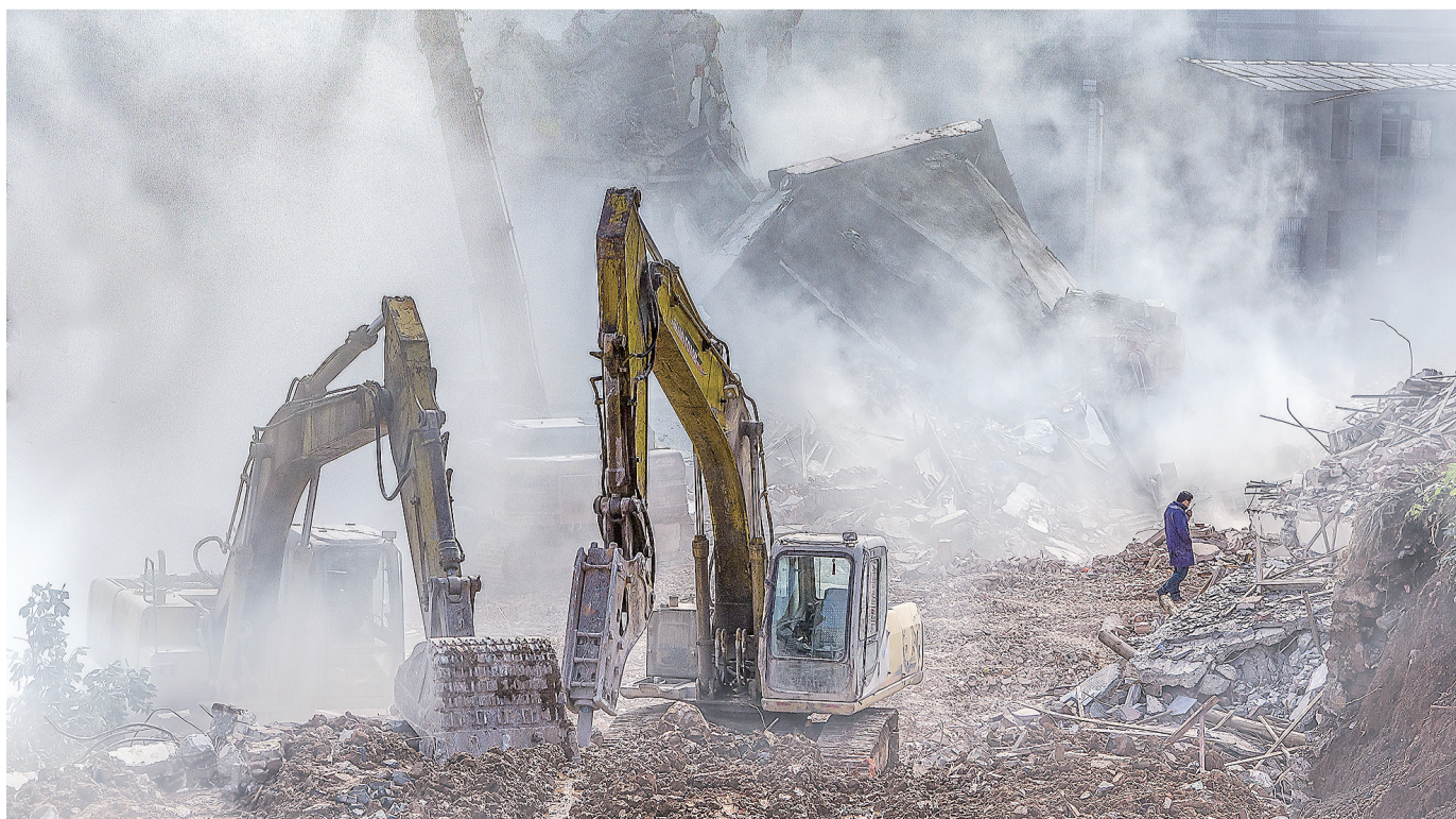
▶ 编号 N3 和 N4 房屋拆除现场,为避免夜间工作,多机械协同作业,专业技术要求高。
