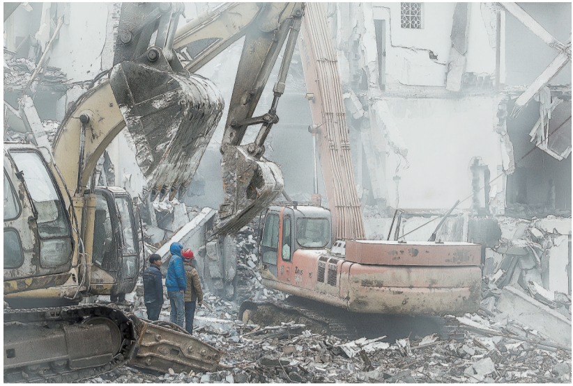
▲编号 NL101 房屋拆除现场,该房屋由多栋紧紧相连的房屋组成,拆除难度大。
