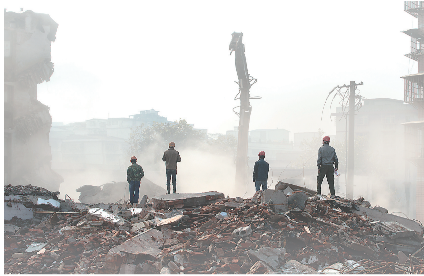
▲编号 NL9 房屋顺利拆除,安全员勘察拆除现场。
