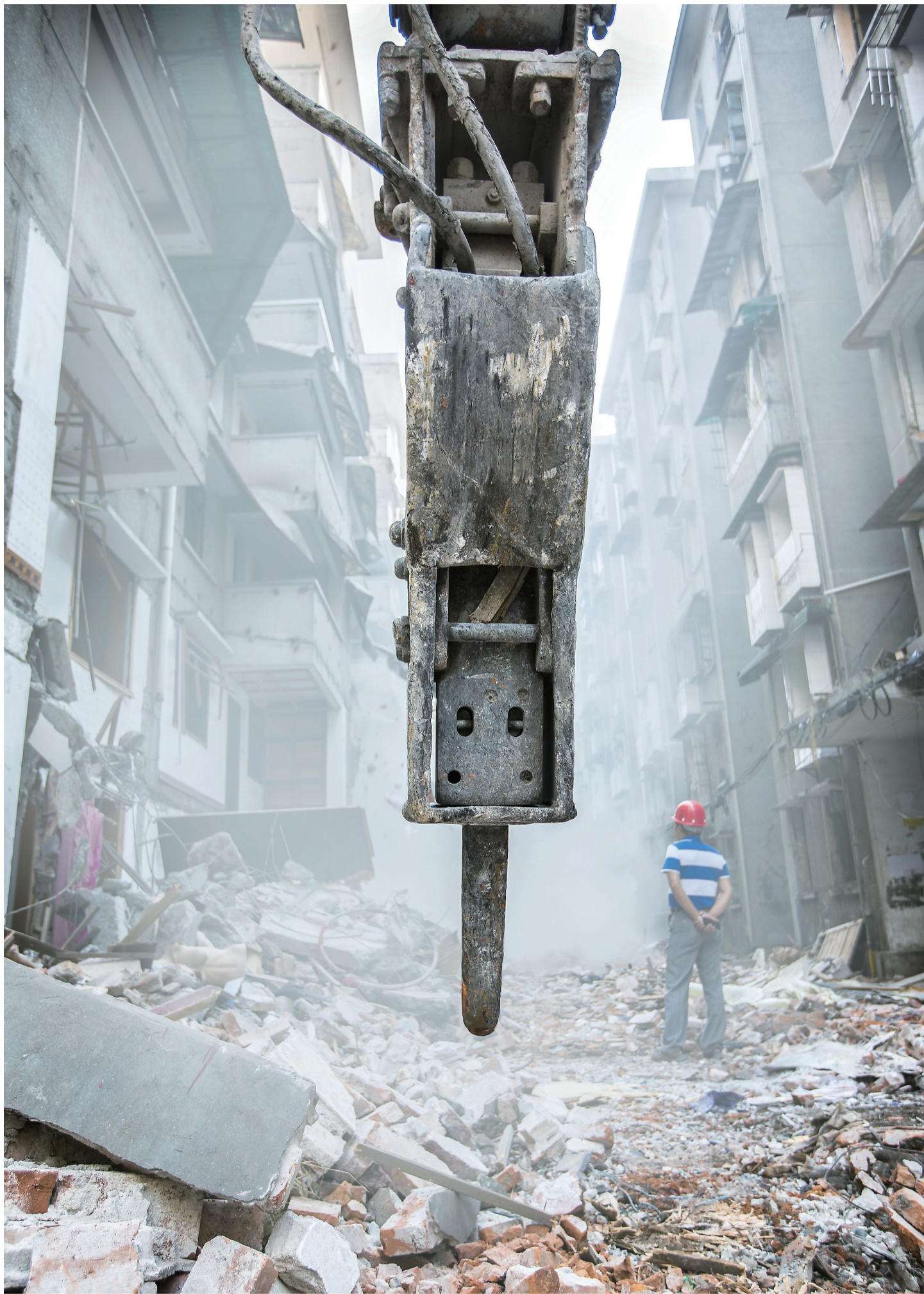
▶ 编号 NL5 的房屋拆除现场,巨大的机械旁,监督员正履行安全监督职责。
